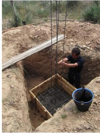
图 2-1 观测墩施工示意图
